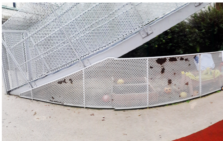
Figure 5- vue de l'escalier sur le coté sud de la cour
